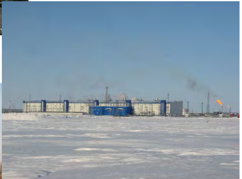
Энергоцентр на ЦПС «Южное Хыльчую», ООО «Нарьянмарнефтегаз»
