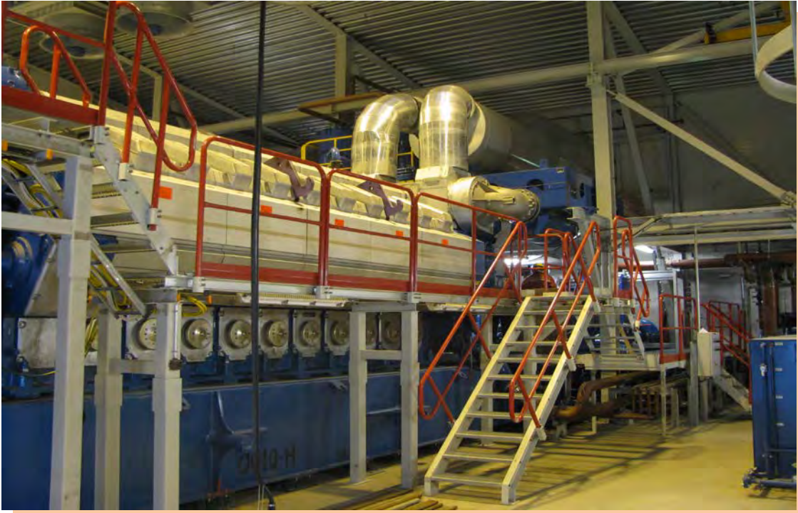
Электростанция на Тарасовском месторождении мощностью 54 МВт с водяными котлами-утилизаторами Заказчик – ОАО «РОСНЕФТЬ-Пурнефтегаз»
