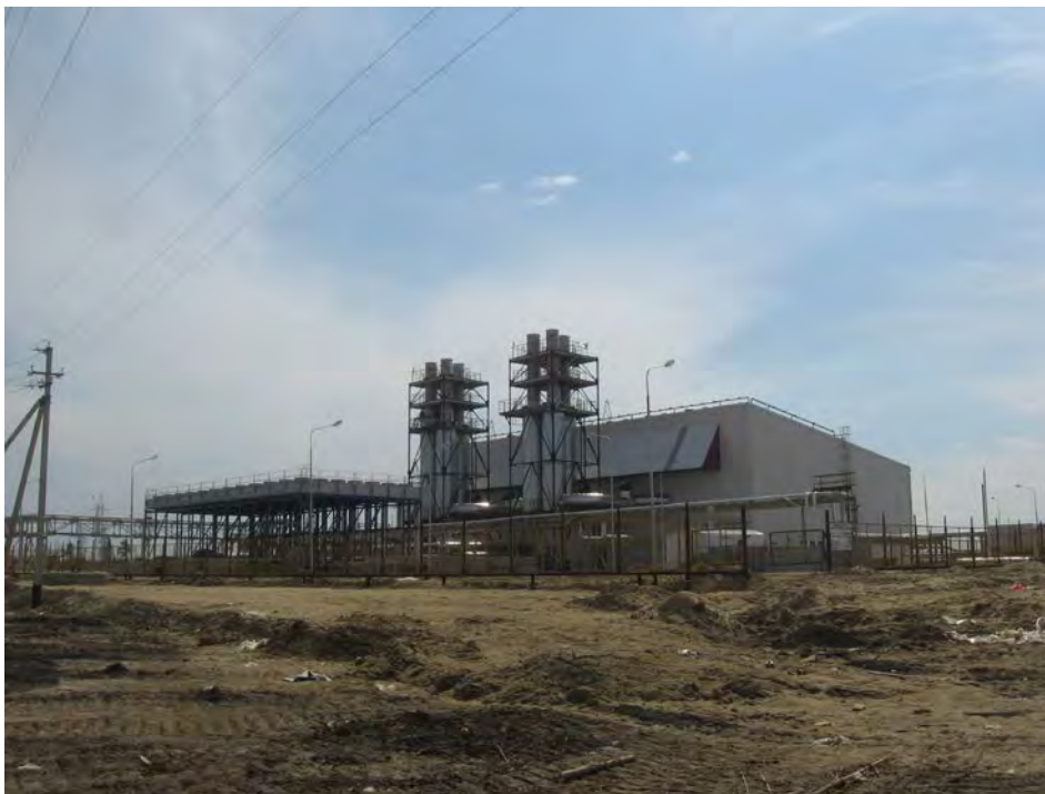
Электростанция на Тарасовском месторождении мощностью 54 МВт с водяными котлами-утилизаторами Заказчик – ОАО «РОСНЕФТЬ-Пурнефтегаз»
